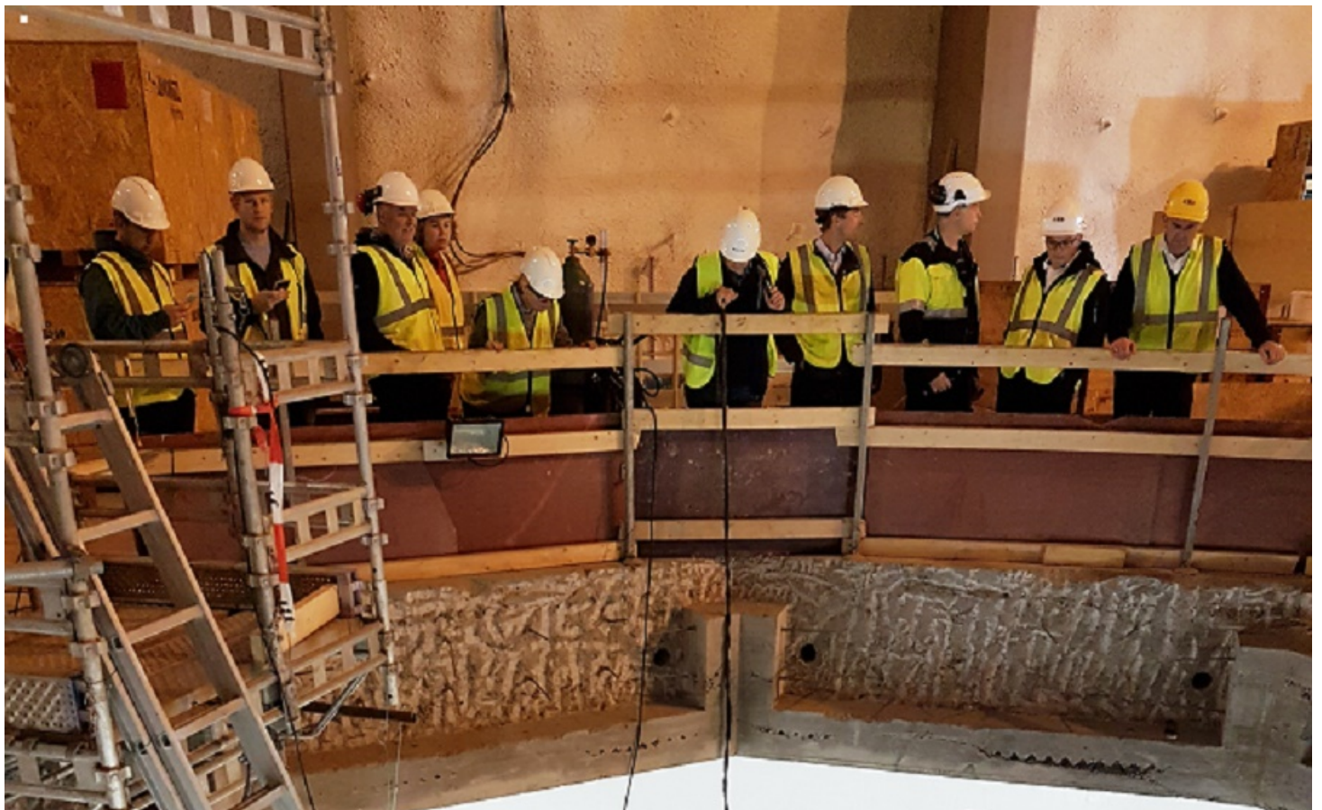
Besøk hos Lyses nye kraftstasjon som er under bygging i Lysebotnen. Foto: Johnny redvik
