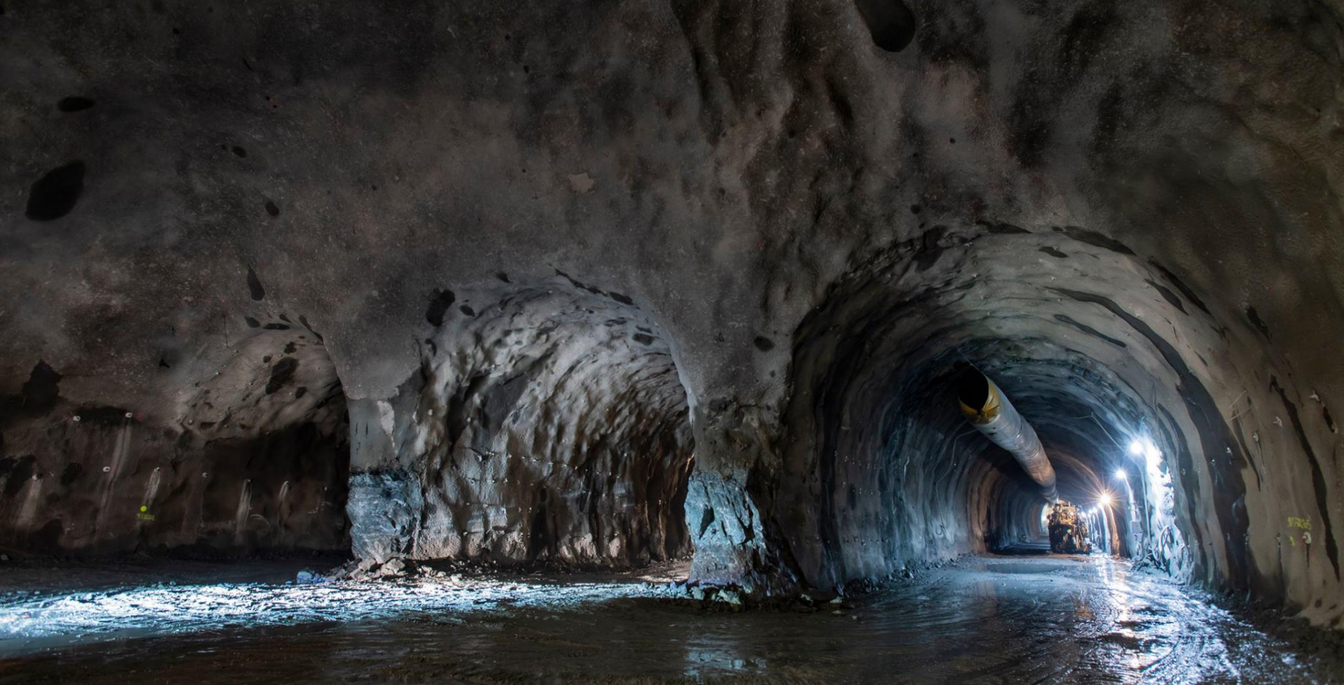
I Tunnelanlegget i Ekebergåsen (Tresporshallen)
