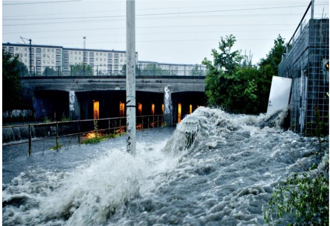
Bilde fra «Overvannstiltak i København og Malmö som kan brukes i Oslo», Bent Braskerud og Vegard Veierød.
