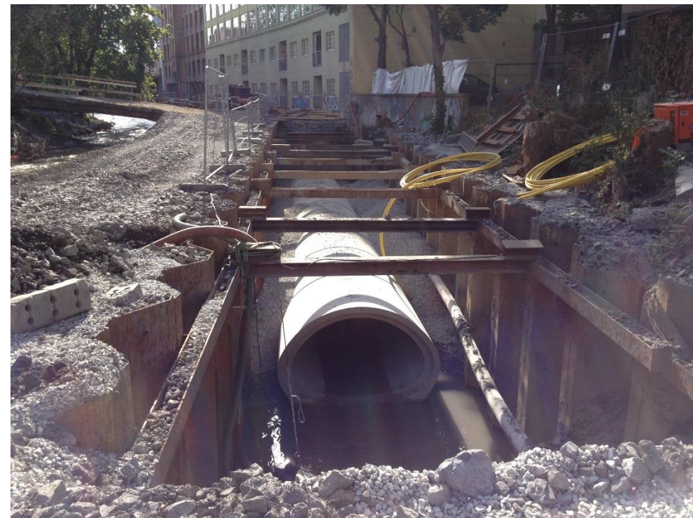
Bilde fra utbygging av Midgardsormen, tatt av Øyvind Bakke, Sweco
